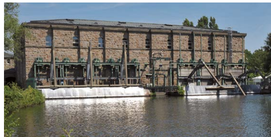
Das Wasserkraftwerk Kahlenberg mit einer Francis-Doppelkammer-Turbine und zwei Kaplan-Turbinen kann 5.000 Haushalte mit Strom versorgen.
